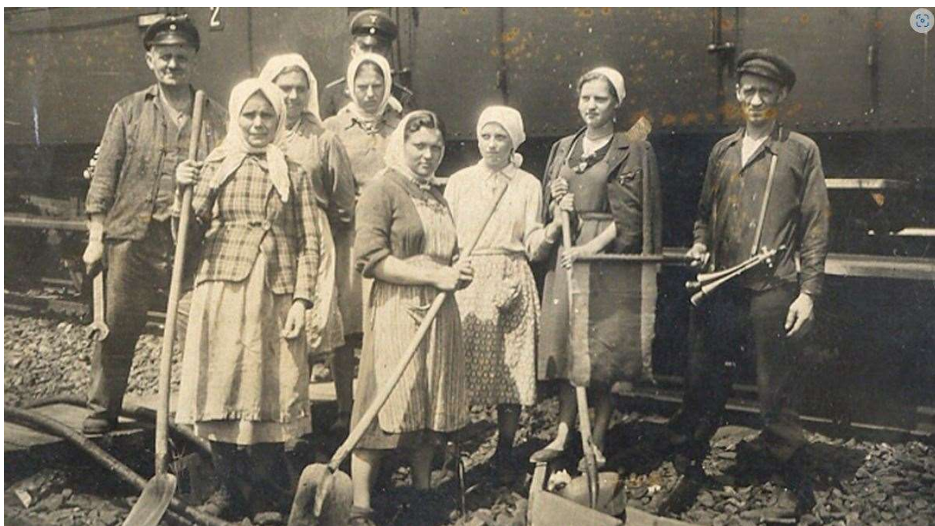
Ukrainische Zwangsarbeiter*innen bei der Ausbesserung zerstörter Gleise für die Reichsbahn an der Bahnlinie Hamburg-Berlin, verm. 1944. © KZ-Gedenkstätte Neuengamme
